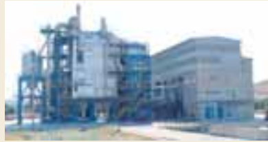
KAPASİTE: 2,2 ton atık/saat BUHAR ELDESİ: 12 ton YBB/saat
